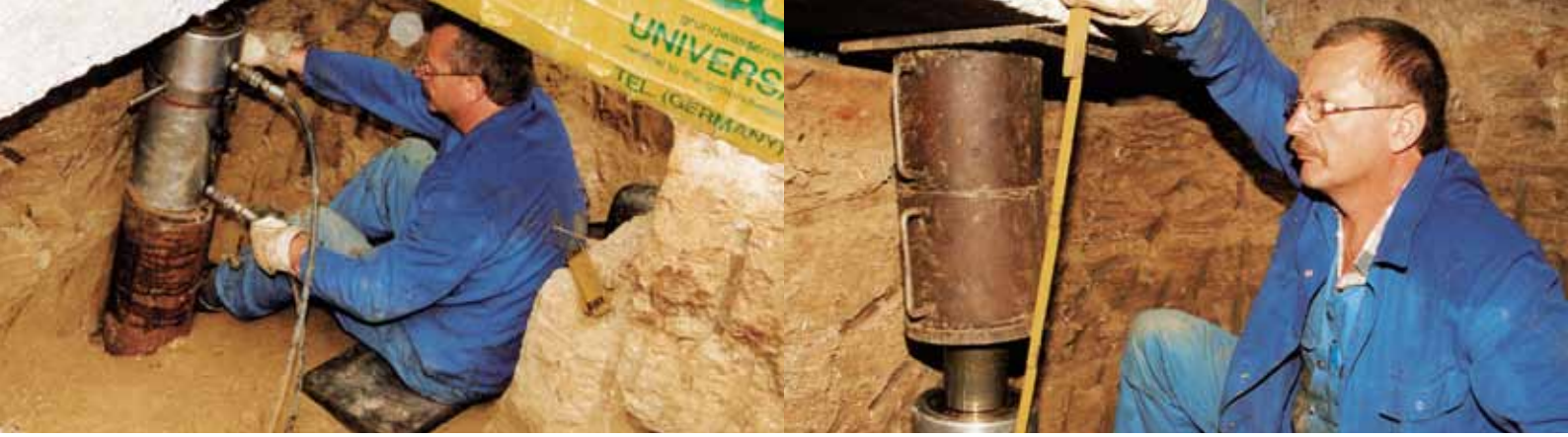
Pressen gegen vorhandenes Fundament
