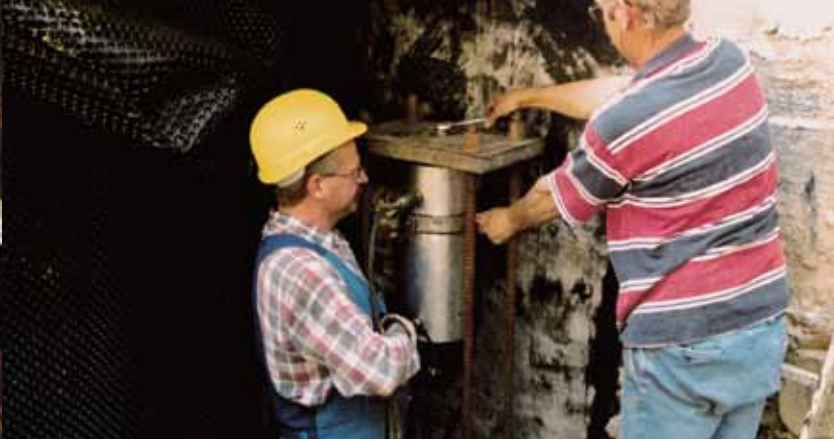
Pressen gegen angeschraubte Konsole
