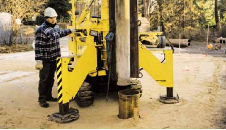
Fertig eingerammtes Stahlrohr
