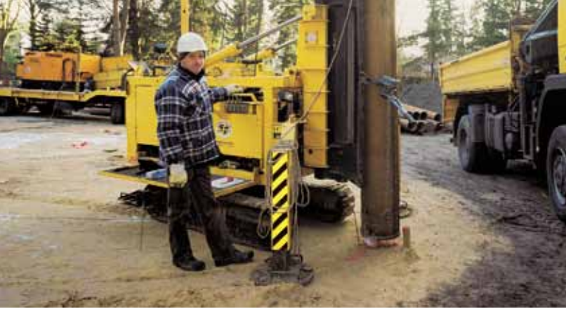
Ansetzen des Rohres
